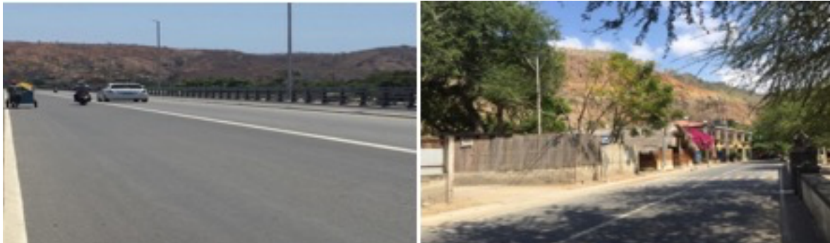
Gambar 6 Kondisi Jaringan Jalan di Desa Metiaut Sumber: Dokumentasi Bapak Januario Mok, 2022
