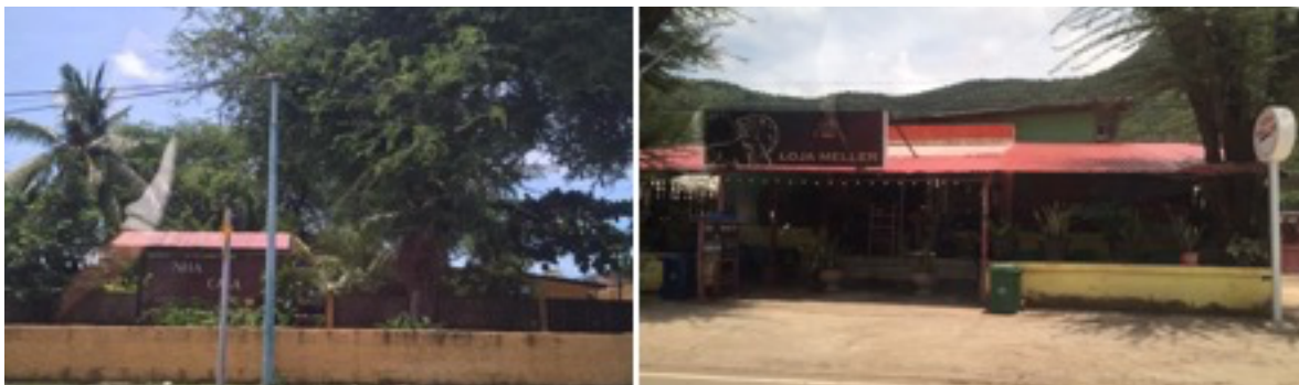
Gambar 5 Kondisi Bangunan Mix Use di Desa Metiaut
