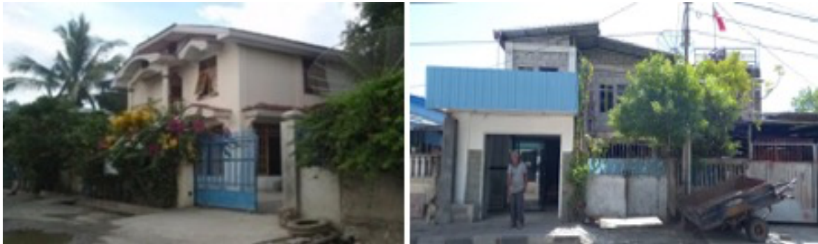
Gambar 2 Kondisi Bangunan Permukiman di Desa Metiaut
