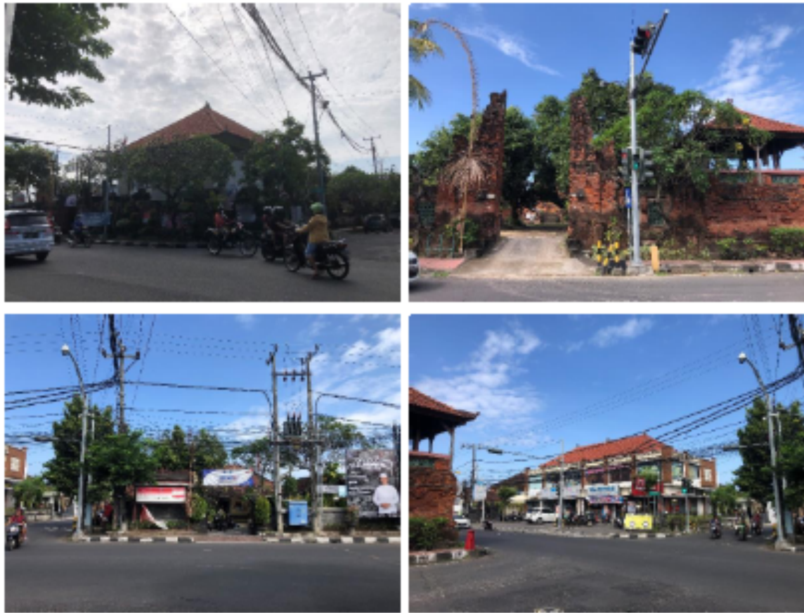
Gambar 1. Kondisi Eksisting Bangunan di Catuspatha Sumber : Observasi Lapangan, 2022
