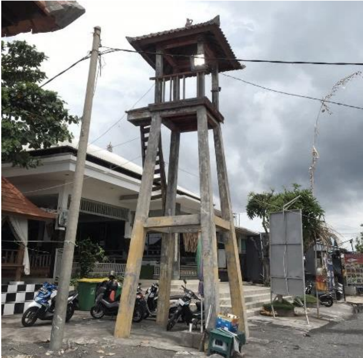
Gambar 1. Dokumentasi Mercusuar 2 Lantai di Desa Lebih Sumber : Dokumentasi Penulis, Tahun 2020
