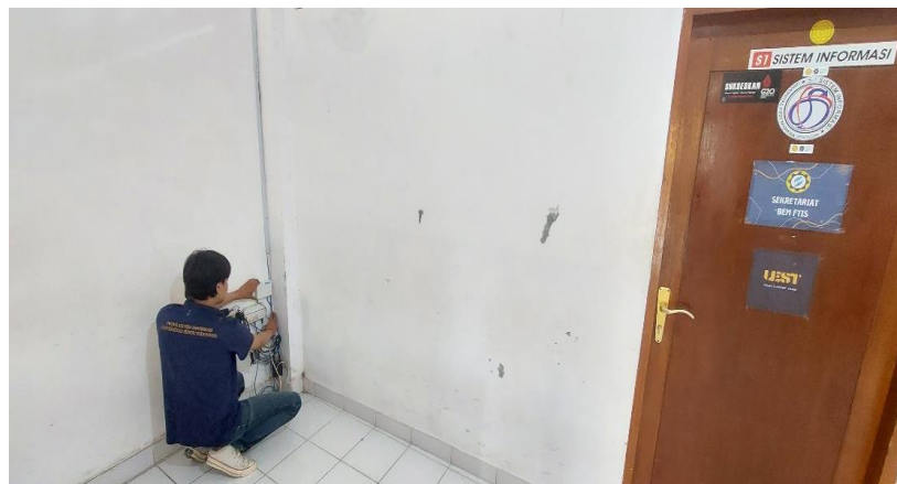
Gambar 4 Instalasi Pemasangan MikroTik
