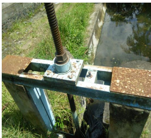
Gambar 2.4 Pintu bangunan pembagi
