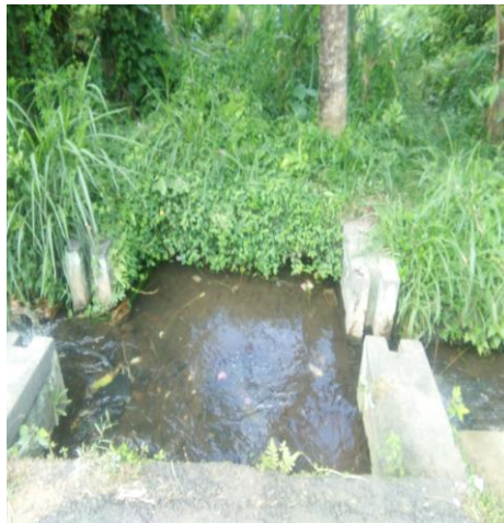
Gambar 2.3 Bangunan bagi di Desa Uma Anyar
